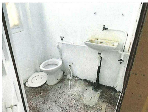
Rez-de-chaussée supérieur – WC séparé
