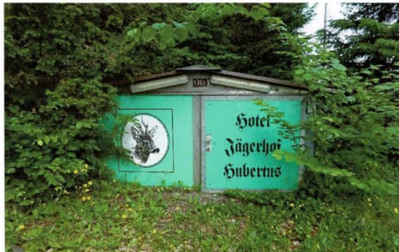
Gebäude Nr. 136B, Pumpenhaus
