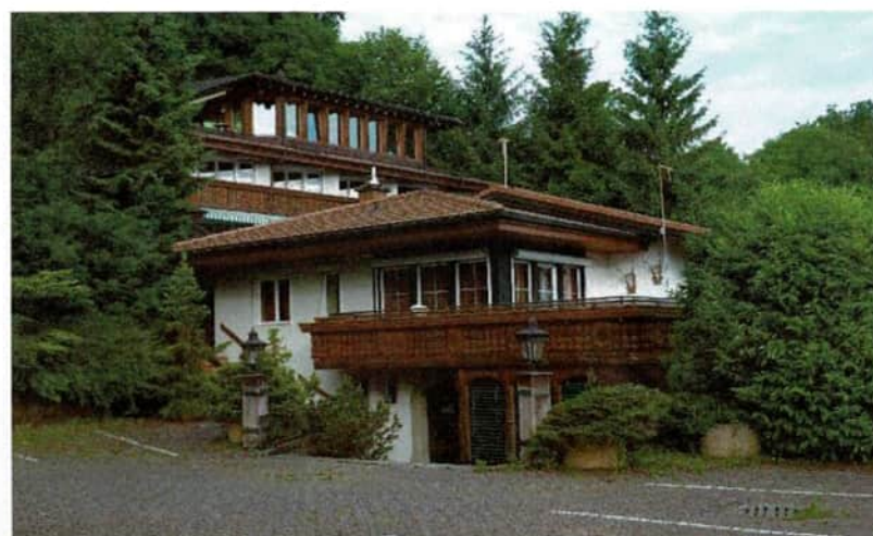
Im Vordergrund, Gebäude Nr. 136, Ostfassade
