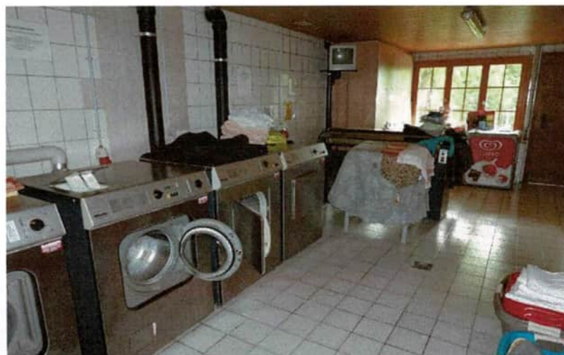
Waschküche, Lingerie Gebäude Nr. 136
