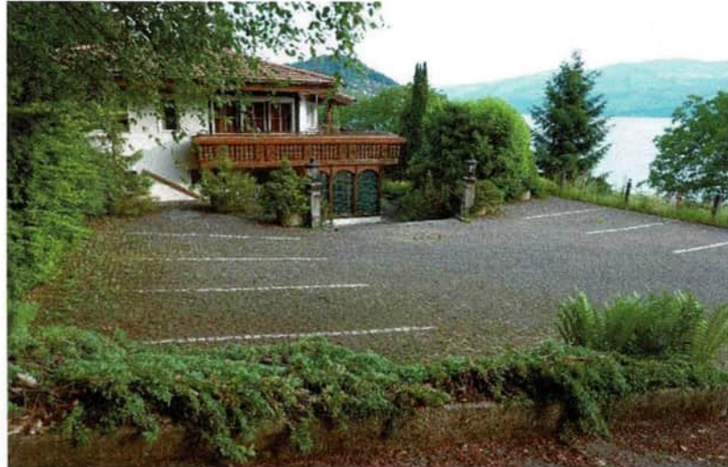
Parkplatz östlich Gebäude Nr. 136
