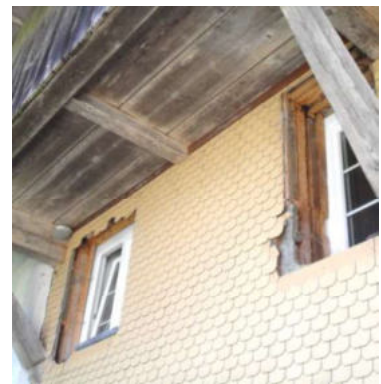
Fenster OG Ostfasade
