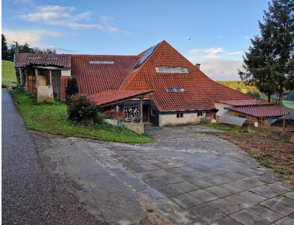
Ansicht Ost mit Unterstand (Guggershaus 31b)
