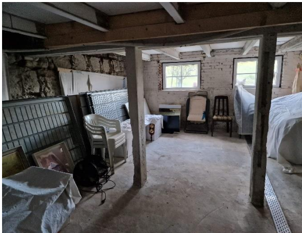
Ehemalige Stallung Guggershaus 31
