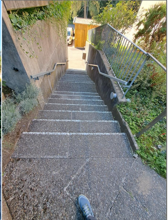
Aussentreppe Ost (Zugangstreppe)
